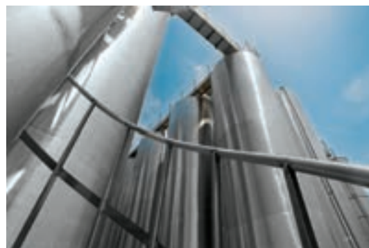
Silos altos y estrechos para almacenaje de polvo y granulado de plástico.
