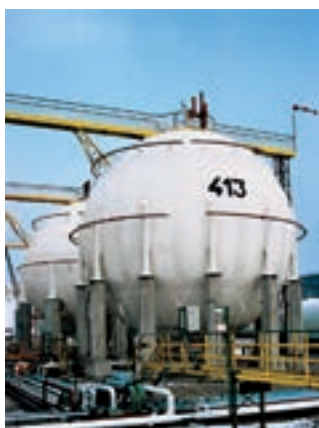
Tanques de almacenamiento de GLP.
