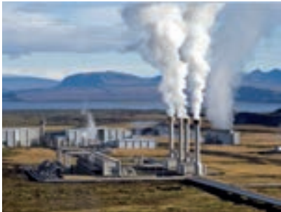
Planta de energía geotérmica.
