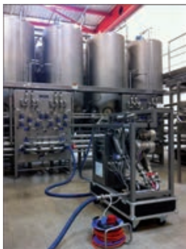
Servicios de calibración, cubicaje y aforo.
