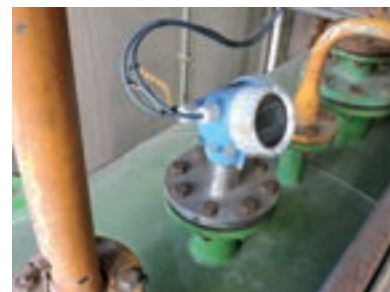
El instrumento seleccionado ha sido el radar guiado Levelflex FMP55.
