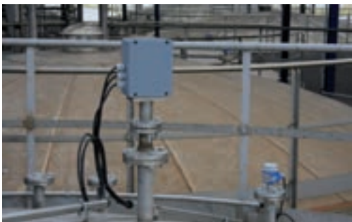
Con el sensor de temperatura se controla la fluidez del producto, evitando paradas de suministro por solidificación.
